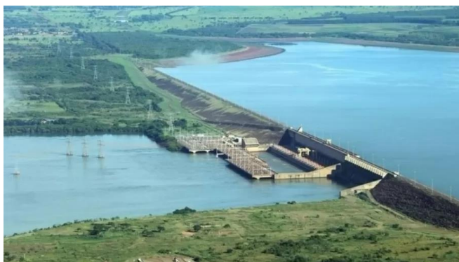
Hidrelétrica de Ilha Solteira no rio Paraná (MS/SP)
