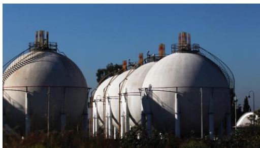
Tanques de gás natural liquefeito
