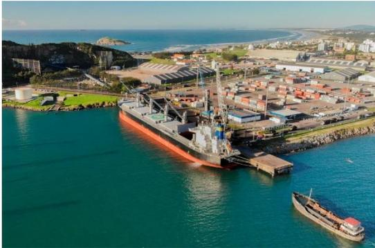
Construído há mais de 40 anos, atualmente o Cais 3 é responsável por cerca de 30% da movimentação do porto. A recuperação e reforço do atracadouro irá viabilizar o recebimento de navios maiores no local, passando do limite atual de 205 metros de comprimento total para embarcações com até 271 metros. Também permitirá a instalação de novos equipamentos de movimentação de cargas, como um shiploader de até 2.500 toneladas/hora, aumentando a capacidade operacional do Porto de Imbituba.
