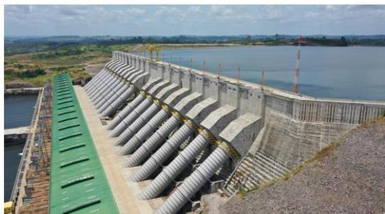
**Com investimento de quase R\$ 40 bilhões, Belo Monte foi construída a fio d'água, sem reservatório**
