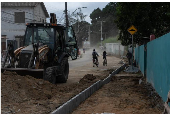
Obras no bairro Bacaxá, em Saquarema, no Rio de Janeiro - Tércio Teixeira/Folhapress
