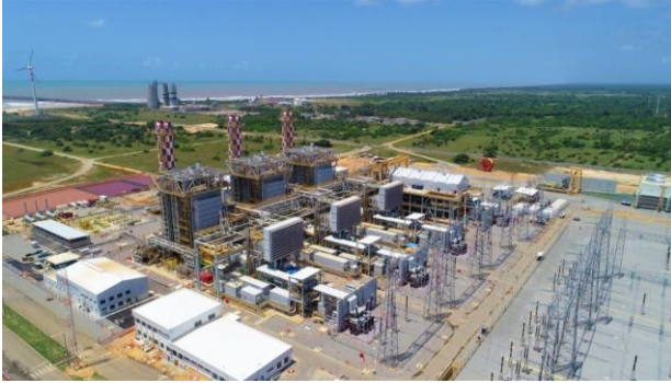
Usina termelétrica Porto Sergipe I, operada pela Celse — Foto: Reprodução
