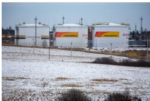
Tanques de armazenamento de óleo em um campo petrolífero da Rosneft na Rússia Andrey Rudakov/Bloomberg
